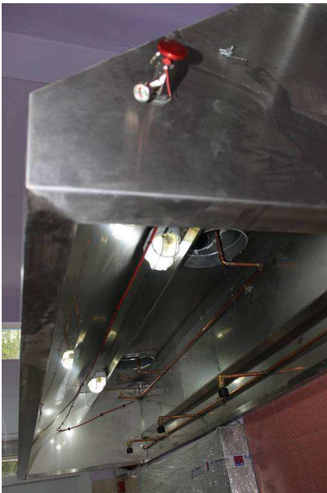
Εικόνα 7. Σύστημα με πλήρη στεγανότητα και εξισορροπημένη πίεση έτοιμο προς λειτουργία
