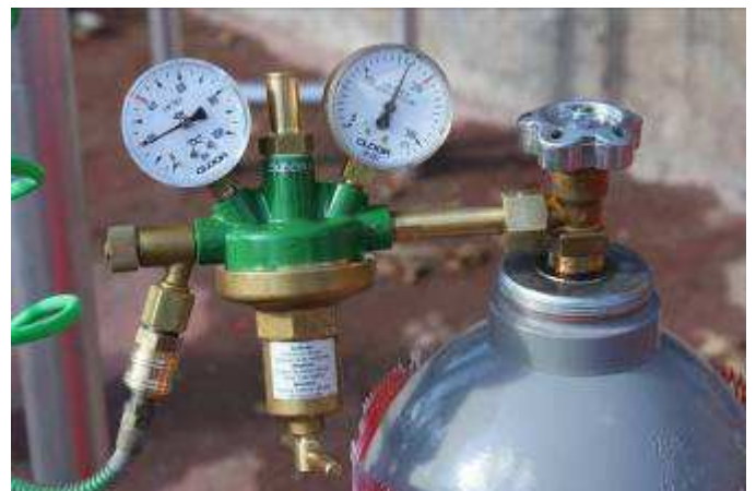
Εικόνα 6. Διαδικασία πλήρωσης του σωληνακίου ανίχνευσης θερμότητας με άζωτο πίεσης 2 bar (max. 20bar) επιπλέον από την πίεση λειτουργίας του πυροσβεστήρα., με τη βοήθεια του ειδικού αντάπτορα πλήρωσης
