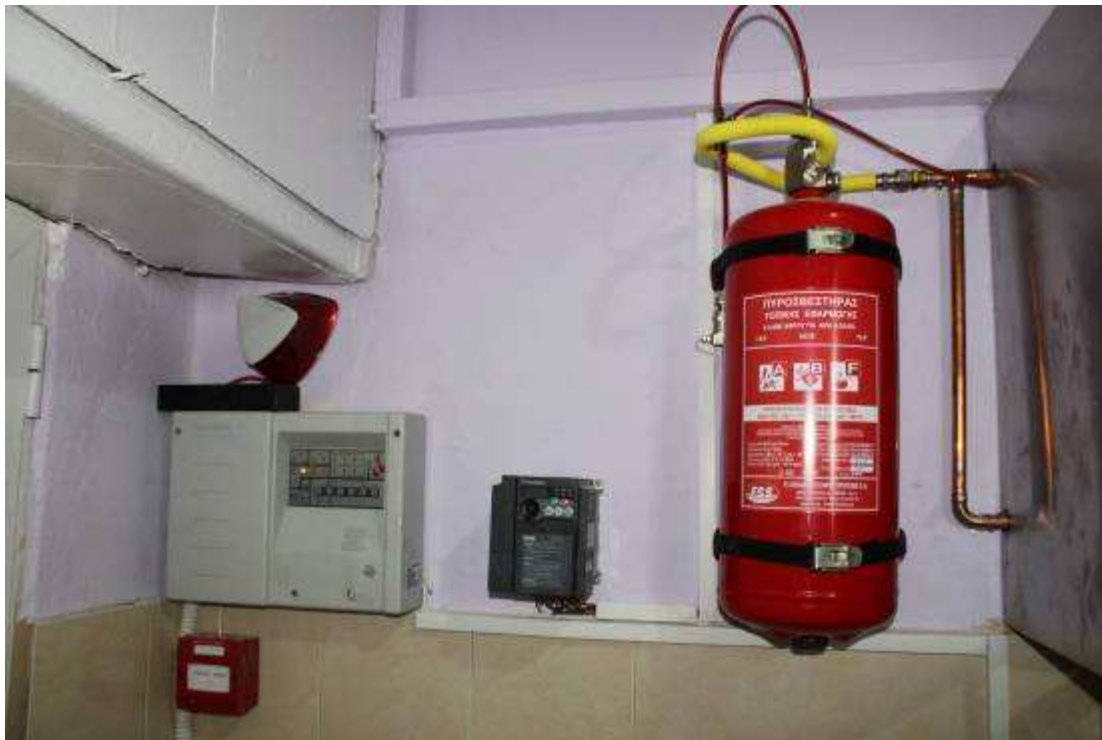
Εικόνα 3. Τοποθέτηση του επιλεγμένου πυροσβεστήρα αφρού.
