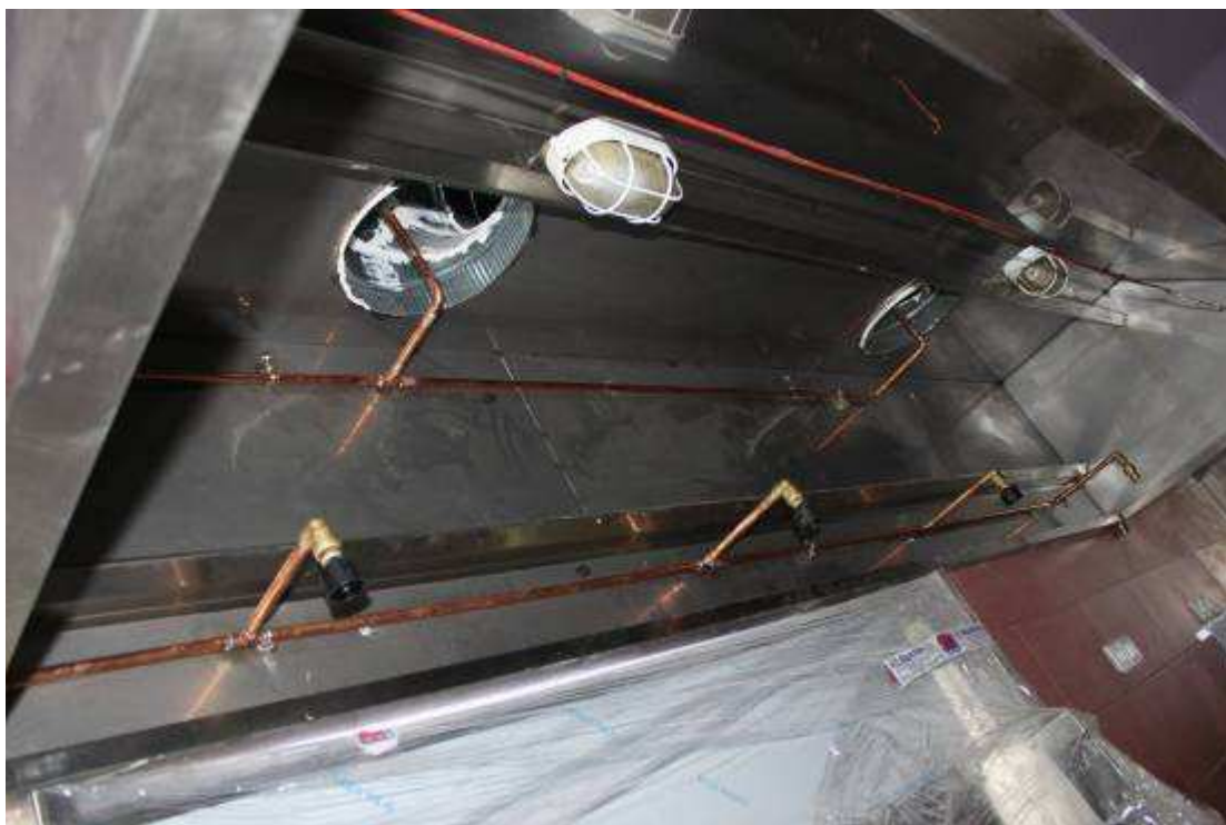
Εικόνα 4. Εγκατάσταση δικτύου χαλκοσωλήνων και τοποθέτηση των κατάλληλων ακροφυσίων στις κατάλληλες θέσεις ανάλογα με την κάθε περίπτωση.
